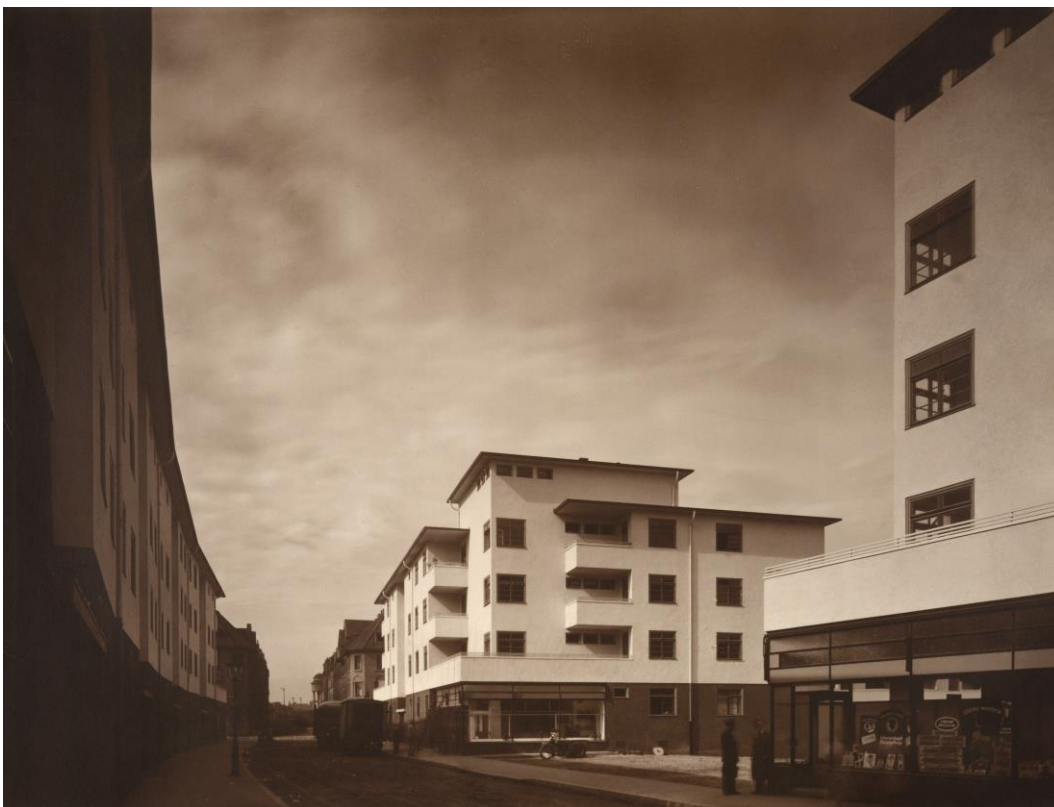
Kasselerstrasse met hoekhuizen van de 'Blauer Hof', architecten Wilhelm Riphahn en Caspar Maria Grod, Kalkerfeld, Keulen (1927) © Werner Mantz / Nederlands Fotomuseum
